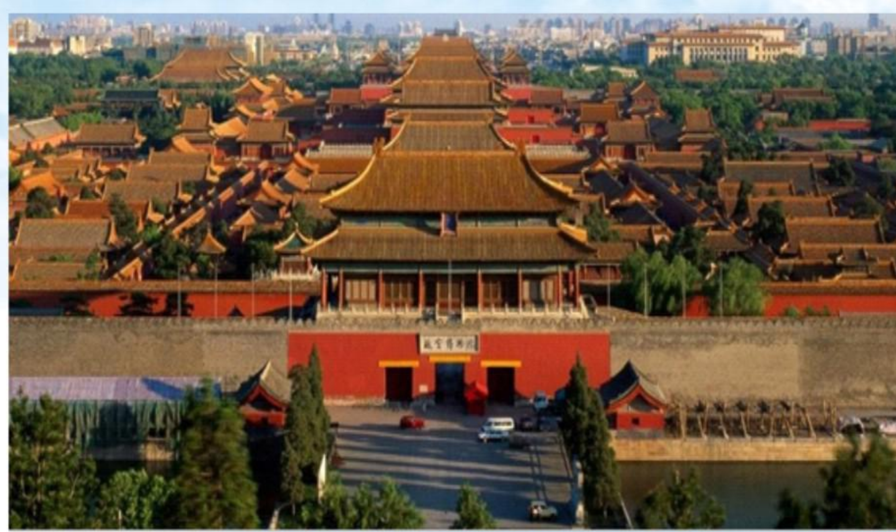
图2（古代）故宫-最完整的装配式木质结构的古建筑群
